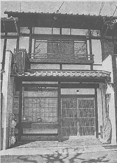
全面リフォームして日本酒バーと宿泊施設を同居させた京町家(京都市北区北大路通堀川西入ル)
